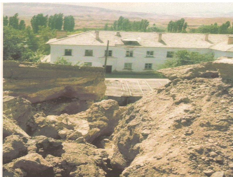
Рис.4. Оползень в пос. Шекафтар спустя 40 лет после отработки рудника
