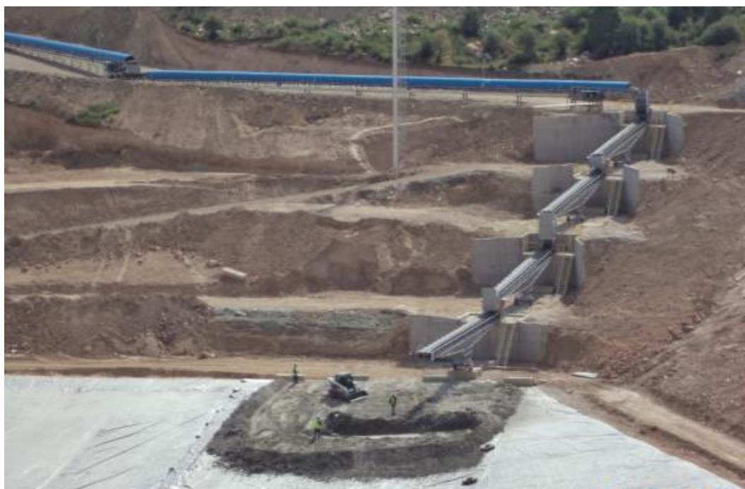
Рис. 2 – Стационарные и ленточные конвейера с цеха фильтрации хвостов на чашу верхнего хвостохранилища
