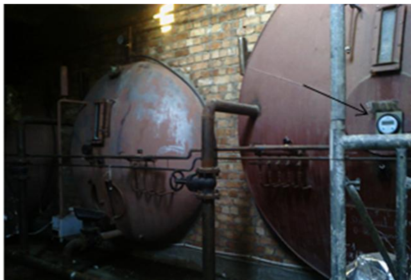
Рис.1. Биогазовая установка с температурным датчиком регулирования
