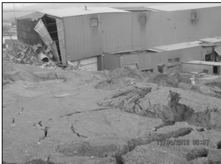
Рис. 8. Надвигание ледово-каменной массы отвалов на здание АТК.
