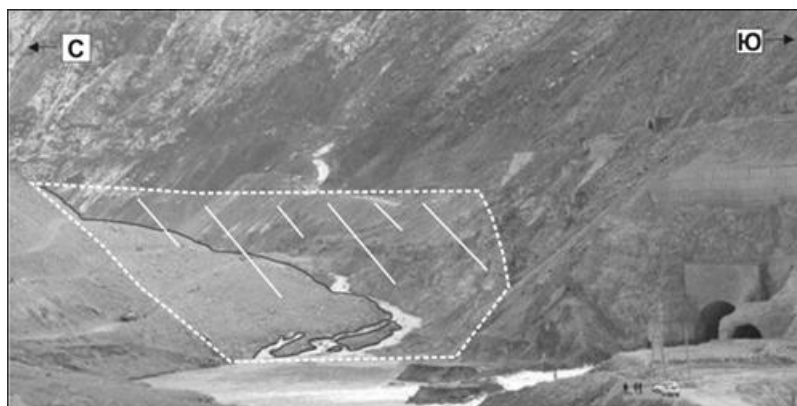
Рис. 1. Проектный (пунктирная линия) и фактический (кёмная линия) контур плотины КГЭС-2 после перекрытия р. Нарын с помощью КМВ
