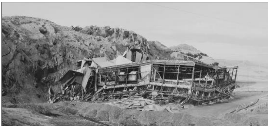
Рис. 4. Вид на фронтальную часть оползающего отвала №3 в июне 2013 г., разрушившей здание администрации и технических служб рудника.
