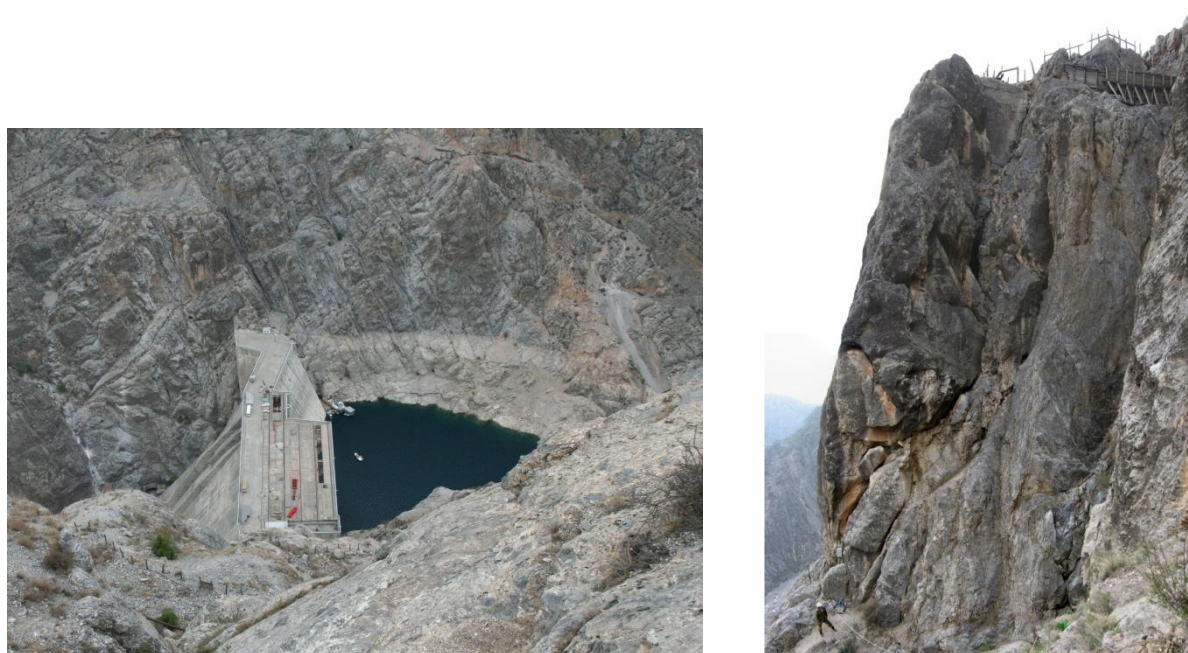
Рис 2. Потенциально неустойчивый массив № 59-1 в правобережном примыкании Токтогульской плотины. Вид со стороны верхнего бьефа.
