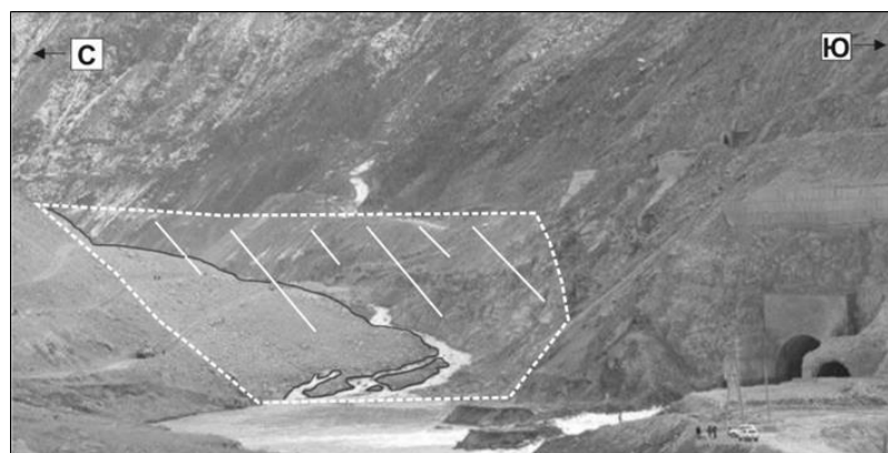
Рис. 1. Проектный (пунктирная линия) и фактический (тёмная линия) контур плотины КГЭС-2 после перекрытия р. Нарын с помощью КМВ
