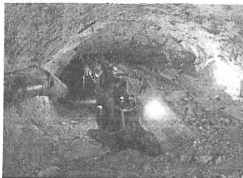
Рис. 2. а – разрушение стенок грота в пещере Синдибобель в результате воздействия тектонических сил, б – несимметричное разрушение стенок незакрепленной выработки шахты «Красная шапочка» в Свердловской области /4/
