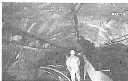
Рис. 4. а – разрушения висячей области крепи выработки, б – обрушенный правый бок крепи горной выработки /5/
